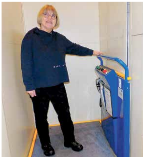
Hissistä se lähti. Tuula Sissala seinättömässä tavarahississä. Käyttöohjeet melkein lattian rajassa, koska seinä ei ole.
